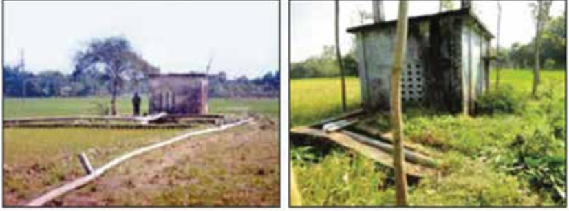
চিত্র ২০। ডিপ টিউবওয়েলে স্থাপিত সারফেস লেইড পিভিসি পাইপ সেচ বিতরণ ব্যবস্থা
