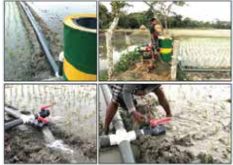
চিত্র ২১। এলএলপি ভিত্তিক সারফেস লেইড পিভিসি পাইপ সেচ বিতরণ ব্যবস্থা
